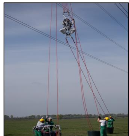
Tűzokvédelmi program – madáreltérítők kihelyezése
